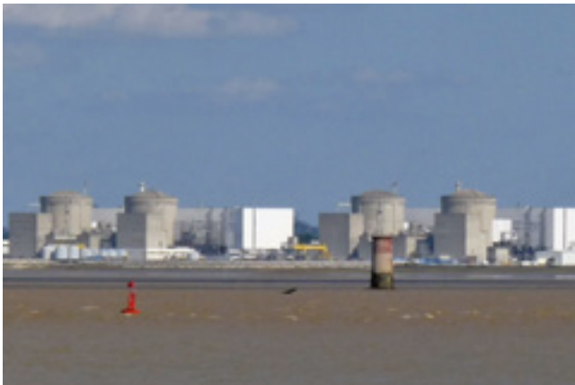
Vier Reaktoren, alle älter als 40 Jahre, alle potenziell rissig
