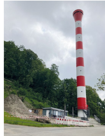
Der Schutt liegt immer noch neben dem Maats am Elbuferweg.
