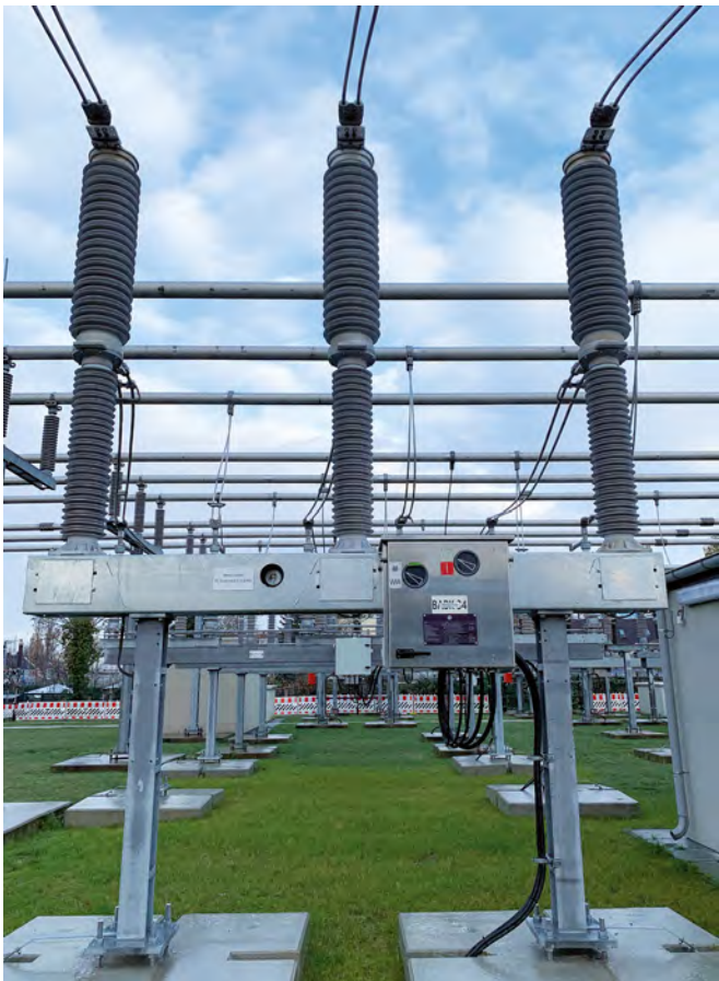
Das 110-kV-Schaltfeld einschließlich Einzelrelaishaus; im Hintergrund die Anbindung des Schaltfeldes an die Rohrsammelschienen der Schaltanlage
