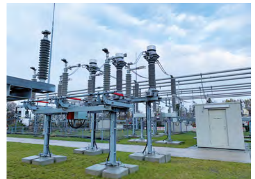
Das 110-kV-Schaltfeld einschließlich Einzelrelaishaus; im Hintergrund die Anbindung des Schaltfeldes an die Rohrsammelschienen der Schaltanlage
