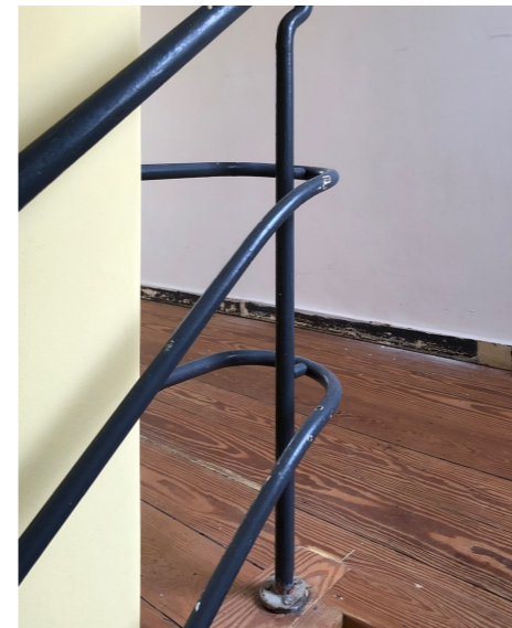
Original erhaltener Handlauf im Haus Spörhase
