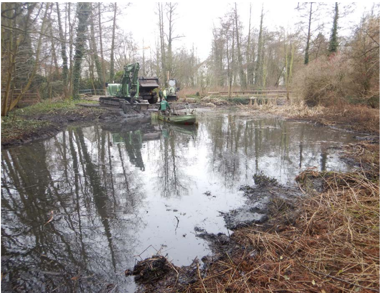
Abb. 2: RHB in der Parkanlage Fischerspark, Hamburg-Wandsbek, während einer Entschlammungsmaßnahme im Winter 2022/23 – © PLANULA 2022 ©
