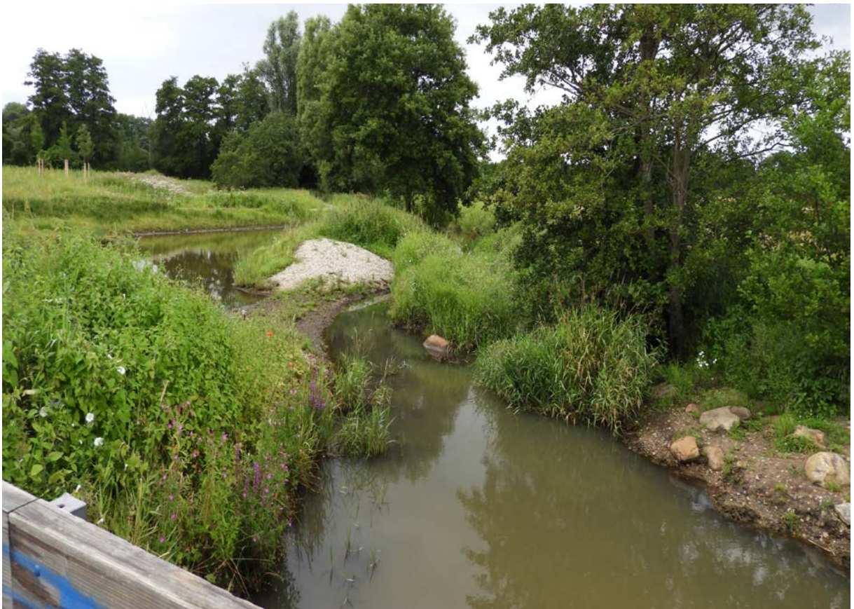
Abb. 16: Sandfang im Nebenschluss Wedeler Au fünf Monate nach der Fertigstellung – © PLANULA 2022
