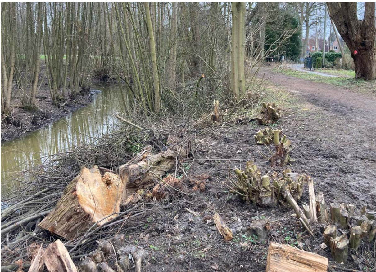
Abb. 13: Schaffung von Totholzhaufen im direkten Umfeld des RHB „Burgwedelau / Grothwisch“, Hamburg-Schnelsen im Rahmen einer Entschlammung im Winter 2022/23 – © PLANULA 2022
