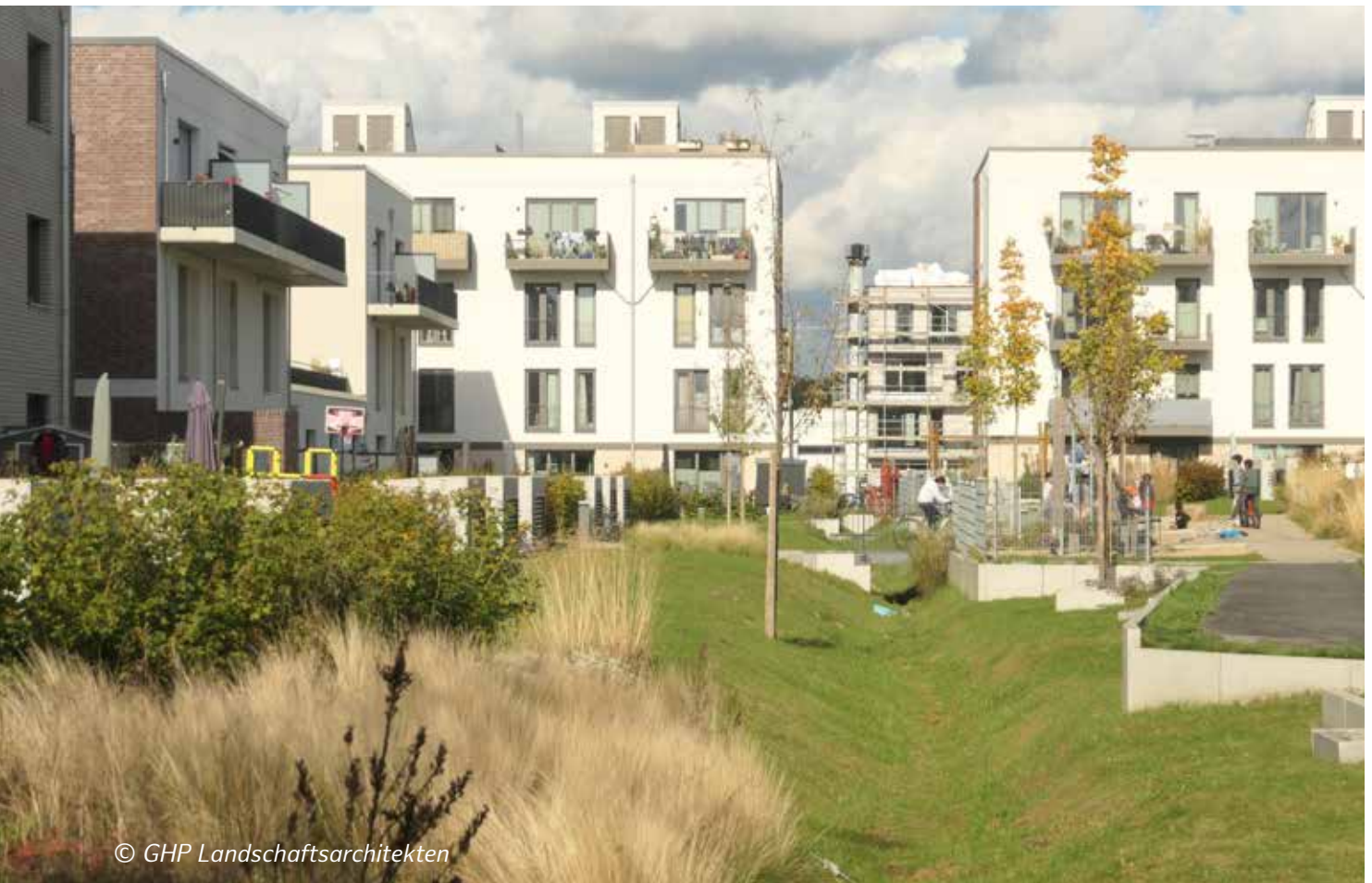
Abb. 40: Regenwasserbewirtschaftung als integriertes Gestaltungselement in Grünflächen - Jenfelder Au FHH
