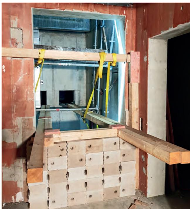
**Gefahrensicherung:** In enger Zusammenarbeit mit der SEG Höhenrettung galt es umfangreiche Sicherungsmaßnahmen und Abstützungen im und am Fahrstuhlschacht gegen herabstürzende Gerüst- und Trümmerteile zu konstruieren
