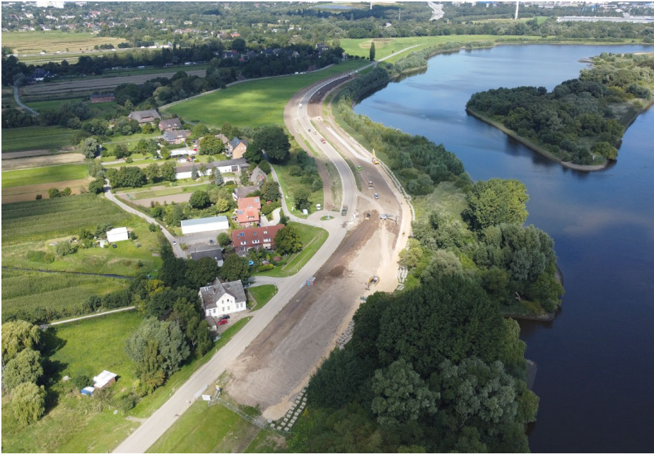
Der Kreetsander Hauptdeich im Ausbau.
