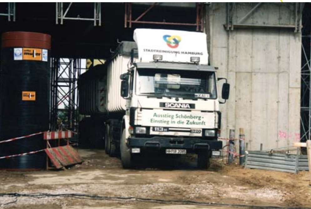
Im August war das Kapitel Deponie Schönberg für die Stadtreinigung Hamburg abgeschlossen.
