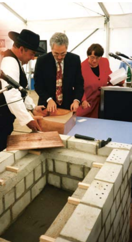
Umweltsenator Dr. Fritz Vahrenholt legte den Grundstein für die Müllverwertungsanlage Rugenberger Damm (MVR).
