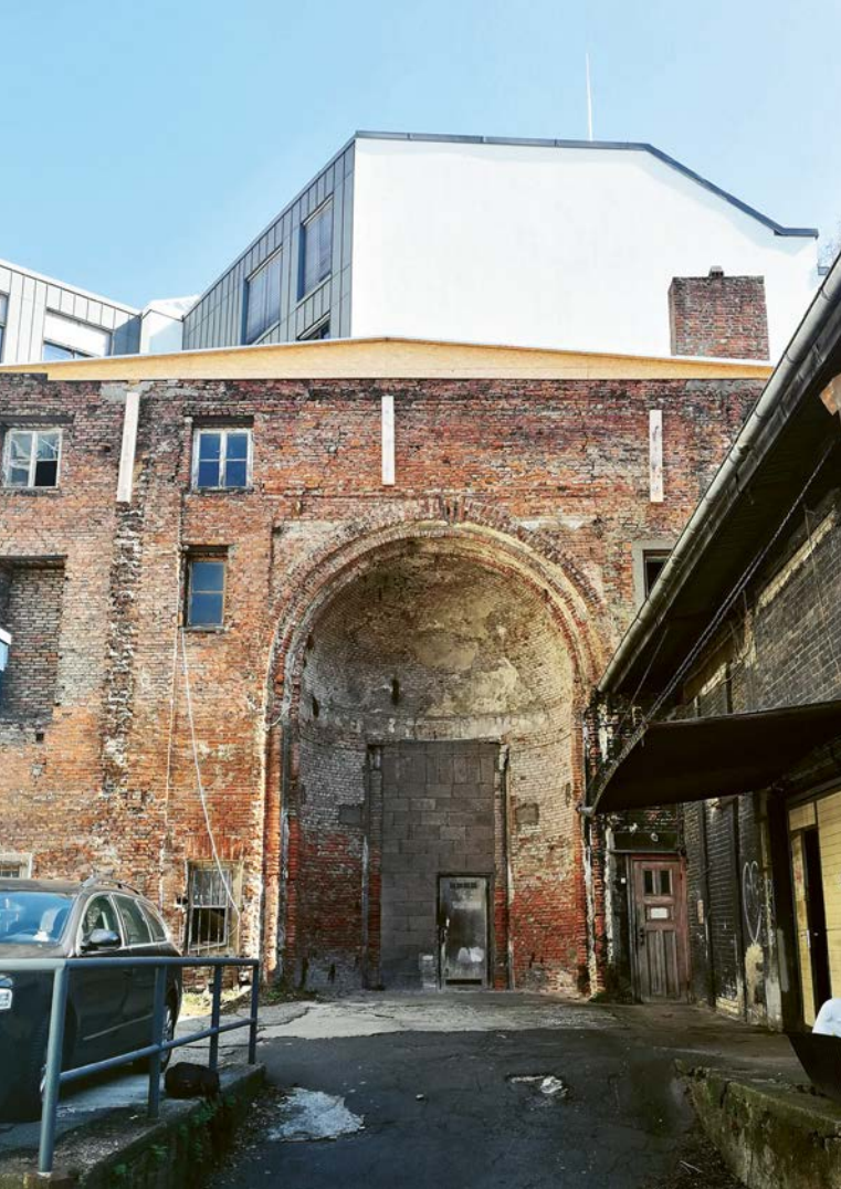
Reste der Ostwand des einstigen Israelitischen Tempels in der Poolstraße.
