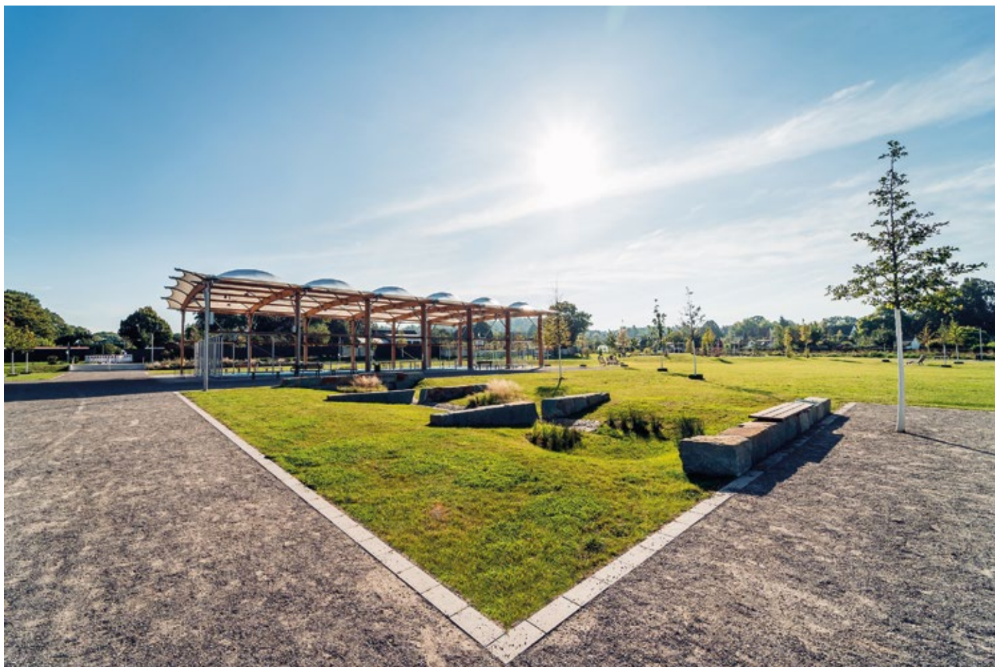
Die Freizeitanlage Hausacker in Bochum ist mit Blick auf Klimaanpassung eine multifunktionale Fläche: Unterirdisch sind Speicher für Niederschlag verbaut, im Starkregenfall wird Regenwasser in Versickerungsmulden gesammelt. (Foto: © Zukunftsinitiative Klima.Werk/EGLV)
