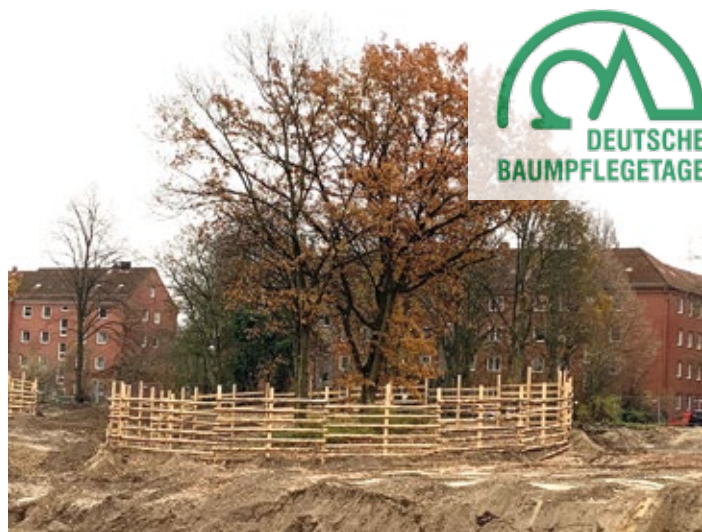
Die zunehmende Nachverdichtung in Städten macht den Baumschutz auf Baustellen wichtiger denn je. Die Deutschen Baumpflegetage 2024 widmen sich dieser Thematik in mehreren Fachvorträgen. (Foto: Deutsche Baumpflegetage)
