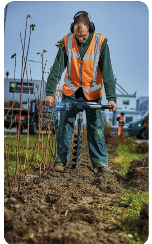
Mit dem Akku-Erdbohrer DG001G lassen sich ohne Mühe komplett kabellos beispielsweise Löcher für Zaunpfosten bohren. (Foto: Makita)
