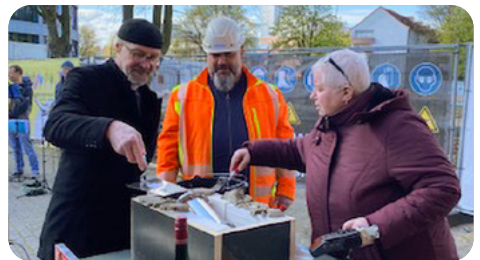
Pastor Morche und Frau Sprenger (Gemeinderat) mauern unter Anleitung von Herr Kuban (Polier) den 1. Grundstein für das Trinitatisquartier © Elisabeth Hartmann
