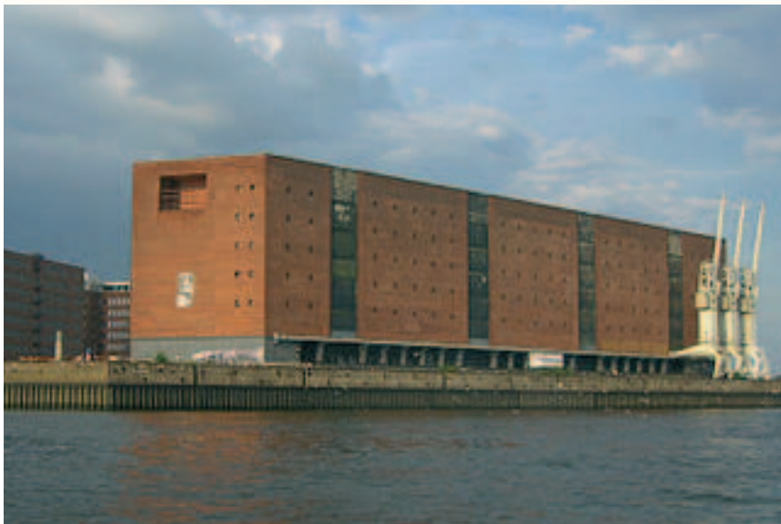
der Kaispeicher A
