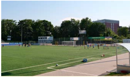
Zwischen dem Kunstrasenplatz im Stadion Hoheluft und dem Lokstedter Steindamm soll die neue Sporthalle errichtet werden.
