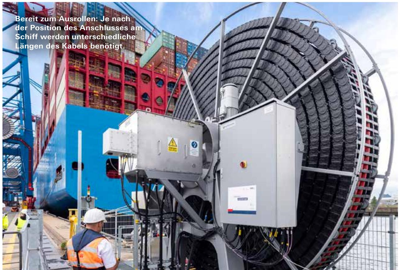
Bereit zum Ausrollen: Je nach der Position des Anschlusses am Schiff werden unterschiedliche Längen des Kabels benötigt.
