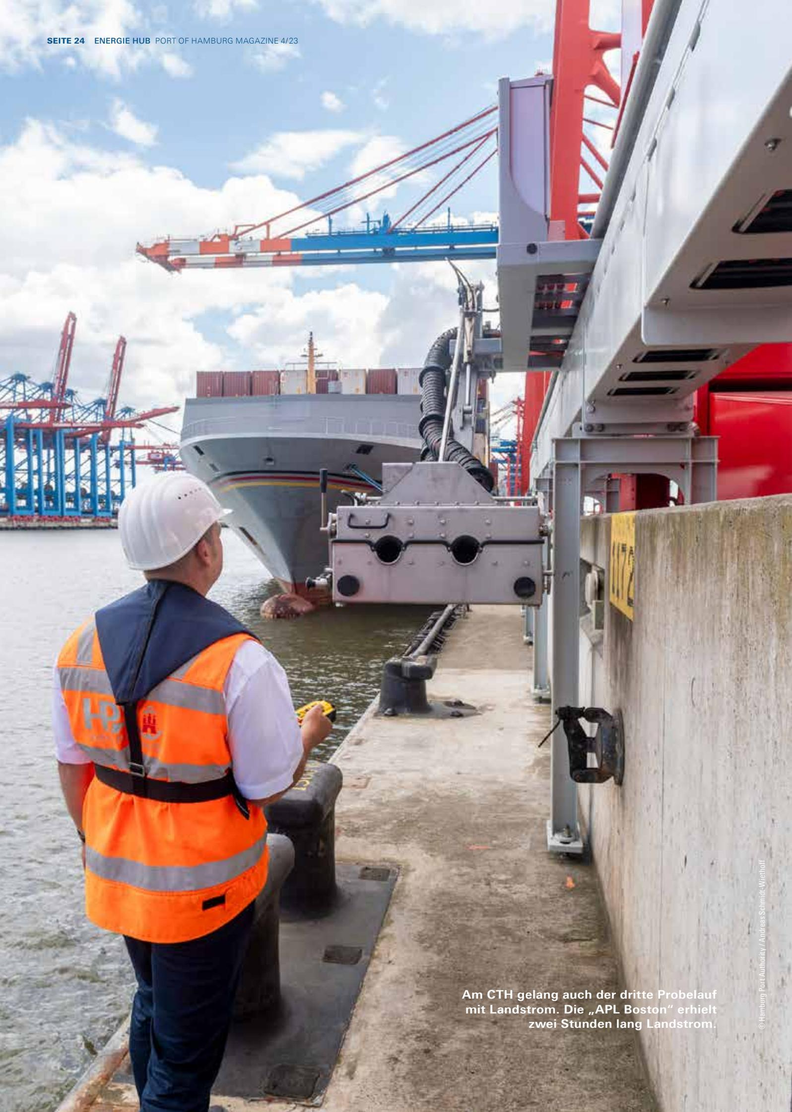
Am CTH gelang auch der dritte Probelauf mit Landstrom. Die „APL Boston“ erhielt zwei Stunden lang Landstrom.
