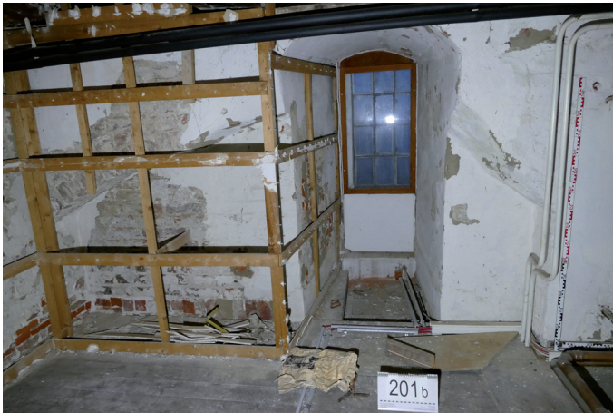
Abb. 44: Galeriebereich vor der Ostwand in Raum 2.01 (auf Höhe ZG2) mit breitem Bogen, gestört durch eine spätere Fensteröffnung, Aufnahme Frühjahr 2022.
