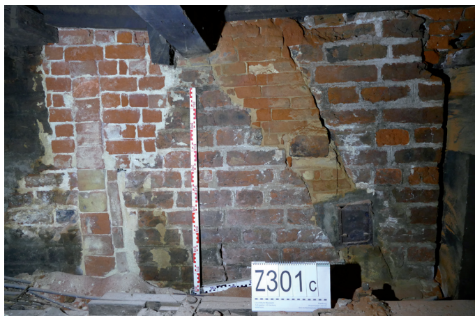
Abb. 52: Zwischengeschoß ZG3, Südwand. Schornsteinzug in der Außenwand, Aufnahme Frühjahr 2022.
