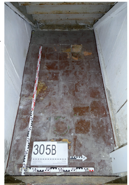
Abb. 52: Fußboden im Verschlag unter der Treppe, Raum 3.05B, Aufnahme Frühjahr 2022.
