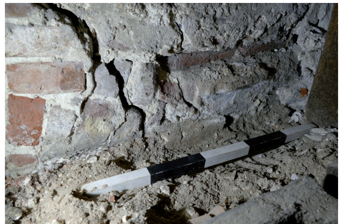
Abb. 51: Zwischengeschoss ZG3, Westwand. Detail zum Rest einer Deckenvoute über Ebene 3, Raum ZG3.01; Aufnahme Frühjahr 2022.
