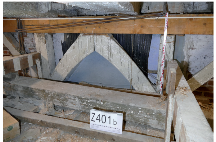
Abb. 56: Ostwand oberhalb der Zwischendecke. Der hölzerne Spitzbogen oberhalb der Ladeluke war zunächst sichtbar und diente rein dekorativen Zwecken. Aufnahme Frühjahr 2022.
