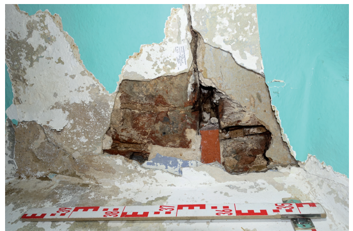
Abb. 42: Blick unter den Sturzbogen des Ostfensters in der Küche, Ebene 2. Unten ist Süden. Das Mauerwerk des Bogens zeigt eine Baunaht. Das östliche (linke) Mauerwerk ist Teil des Baus von 1310; das Mauerwerk rechts der Fuge ist vom Wiederaufbau von um 1380 (Aufnahme Frühjahr 2023).
