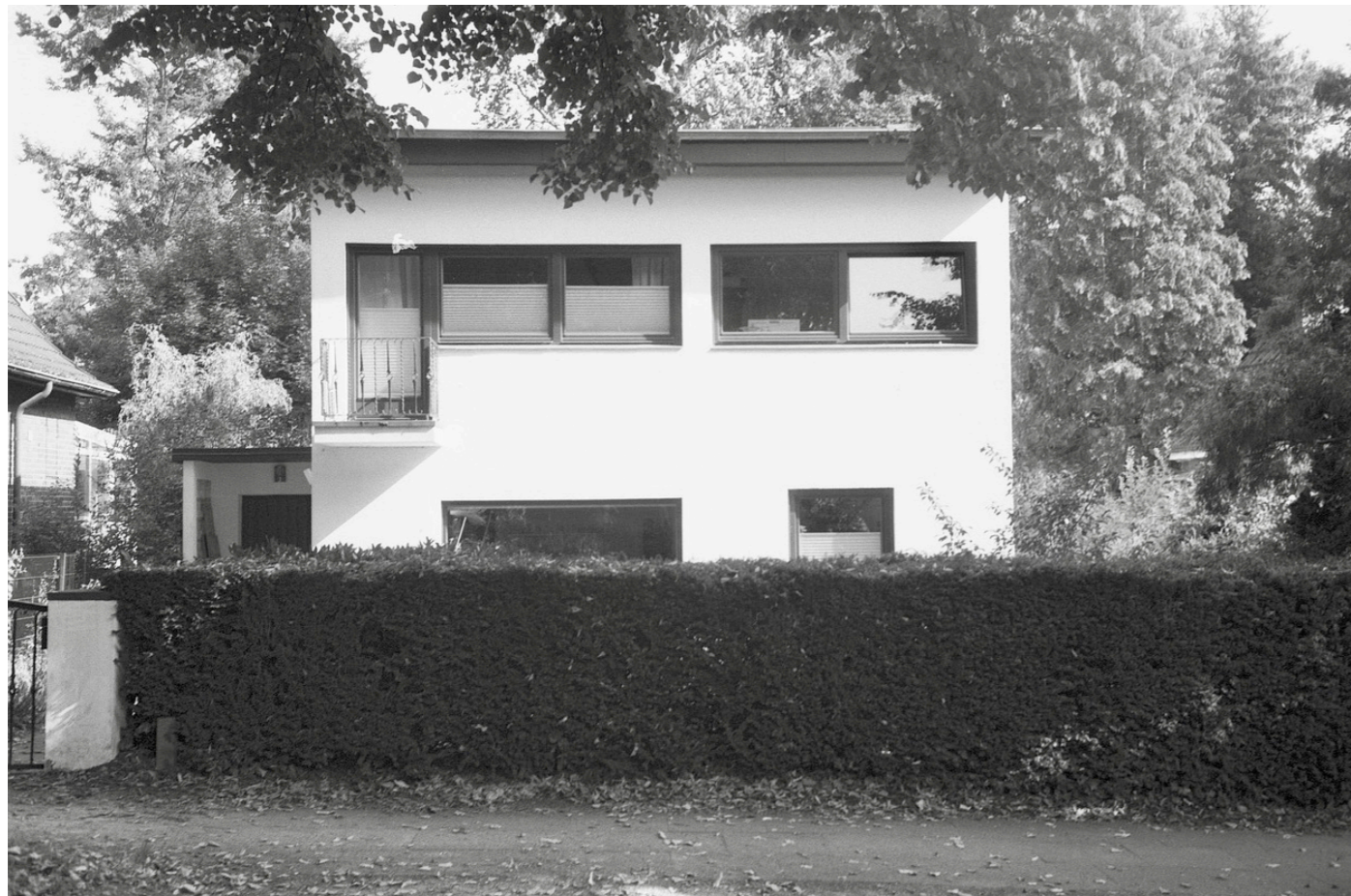
Wohnhaus Lutherhöhe 10 (ehemals Lutherstraße), straßenseitige Ansicht aufgenommen 10.9.2023
