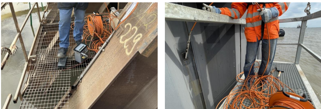
Abb. 22: Inklinometermessung an Schrägpfehlen (links vor Hinterfüllung, rechts im Endzustand)
