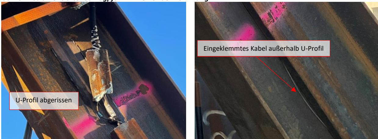
Abb. 26: Instrumentierter Schrägpfahl A-125 während der Rammung
