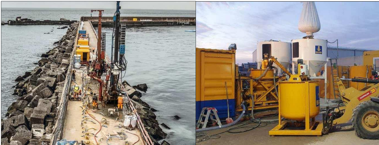
Abb. 12: Sonic-Bohrgeräte auf der Mole in Phase 4 (links) Mischanlage Zementsuspension (rechts)
