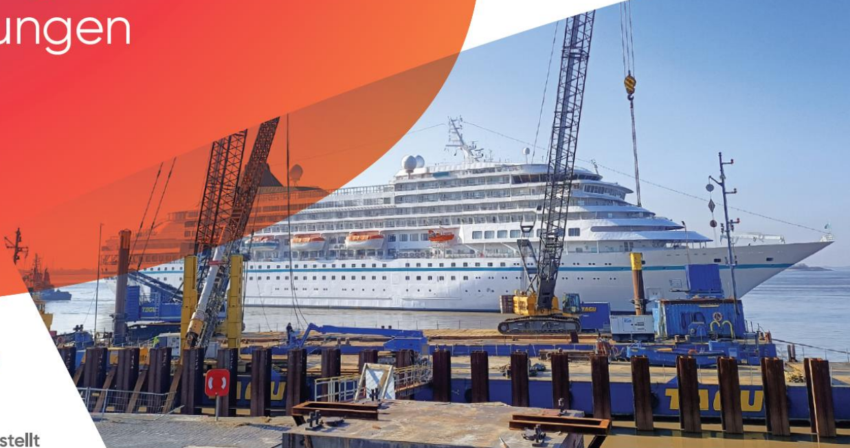
Neubau der Columbuskaje in Bremerhaven (1. + 2. BA) © ARGE Neubau Columbuskaje, Herr zu Putlitz
