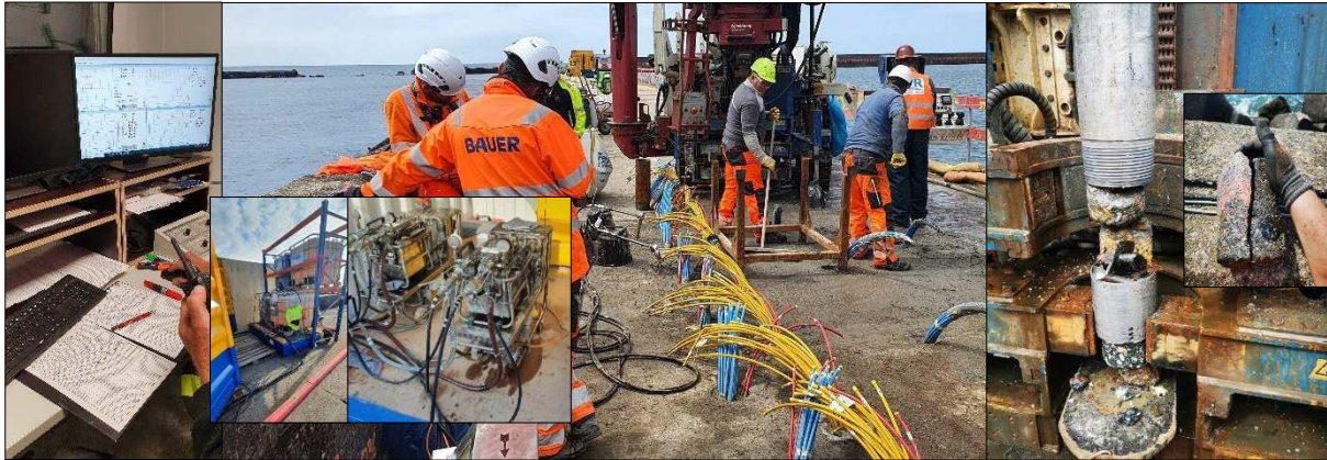
Abb. 8: Ventilrohrbündel, seeseitiger Injektionsschleier
