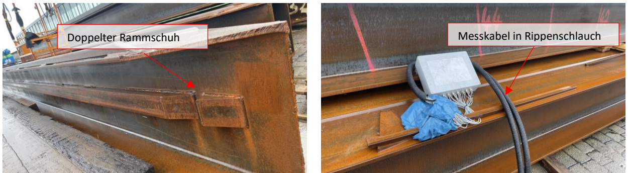
Abb. 27: Instrumentierter Schrägpfahl A-25 vor der Rammung
