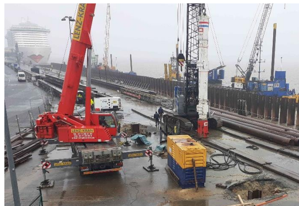
Abb. 12: Dynamische Wiederholungsprüfung an lotrechten Ankerpfählen im 1. BA
