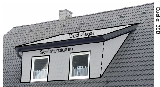
Abbildung 1: Dach mit Gaube.
