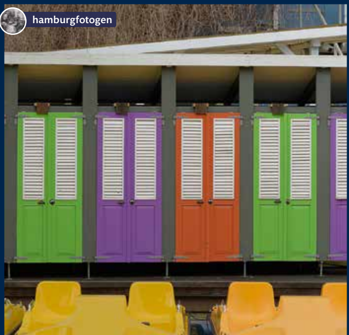
Thomas Becker & Annick Salom: Kabinentüren am Bootshaus Deelböge
