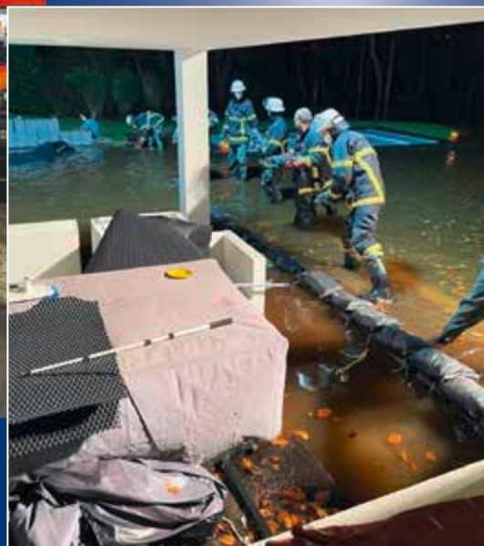
Sandsackverbau in der Straße Reye in Wohldorf
