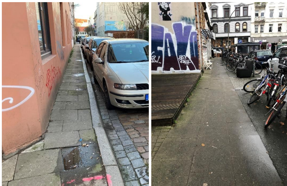
Abb. 2 und Abb. 3: Unzureichende bauliche Breite von Gehwegen.
