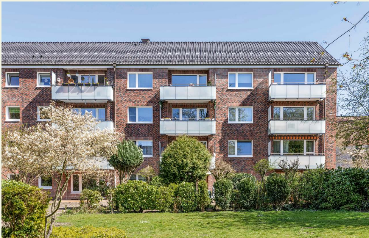
Moderne Balkonbrüstungen aus satiniertem Glas und eine Klinkerriemchenfassade sorgen für eine ansprechende Optik.
