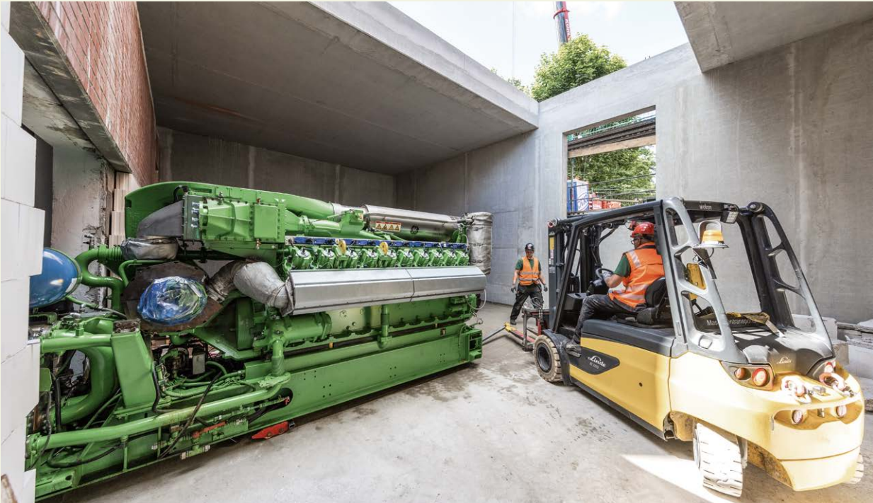
Millimeterarbeit bei der Montage des neuen Blockheizkraftwerks
