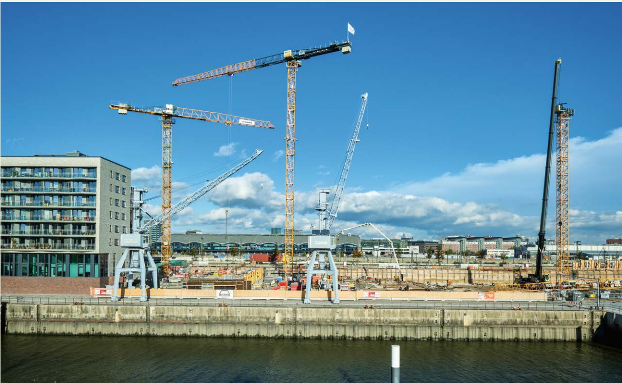
Blick vom Himmelsberg (Baakenpark) auf das Baufeld 84 im November 2022
