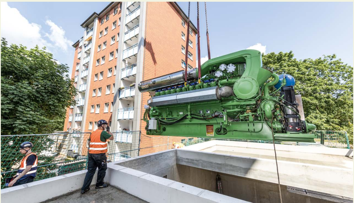
Anlieferung des Blockheizkraftwerks im Juni 2022
