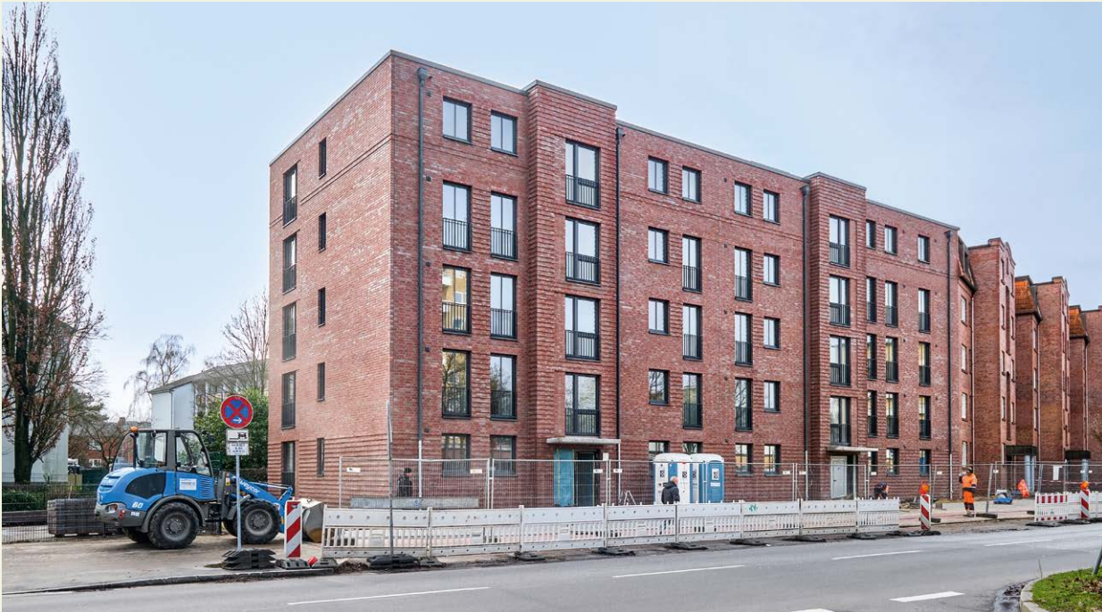
Der Neubau Möllner Landstraße 130 a + b kurz vor der Fertigstellung
