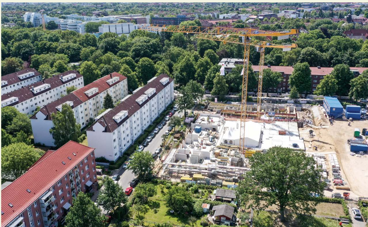
Der Neubau in Barmbek ergänzt den Bestand der Genossenschaft (unten links) optimal. Im Juli 2022 standen die ersten Grundmauern.
