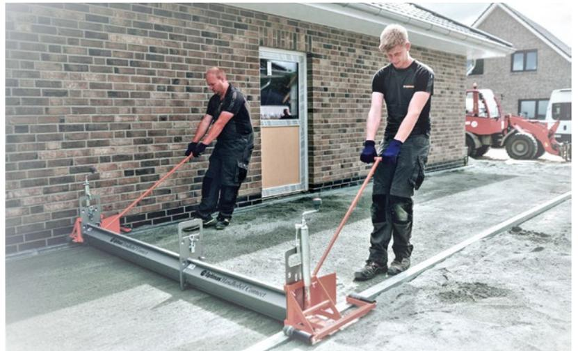
Beim Optimas Handhobel Connect sind die fünf Zwischenteile einzeln oder kombinierbar zu nutzen. (Foto: Optimas GmbH)
