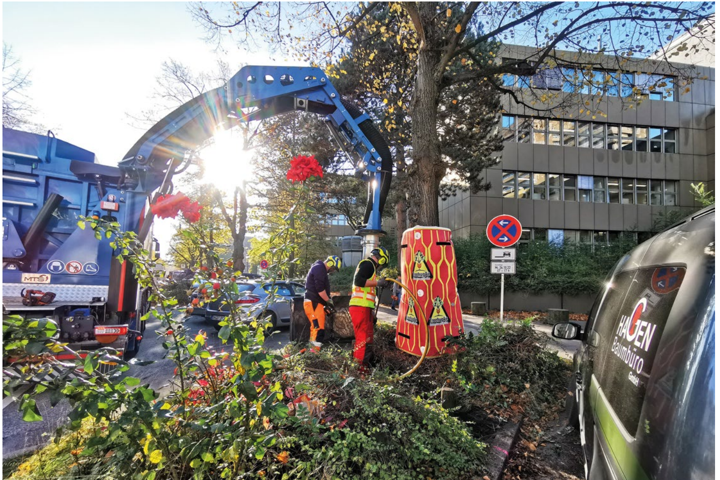
Die neue TreehugAir Baumschutzmatte im Einsatz. (Foto: GEFA Produkte Fabritz GmbH)
