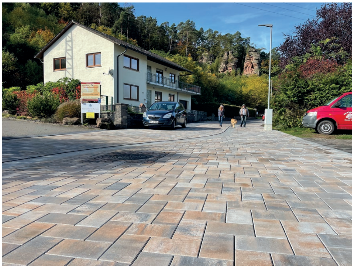
Die Schillerstraße im südpfälzischen Dahn wurde mit dem Pflastersystem COMBICONNECT saniert.
