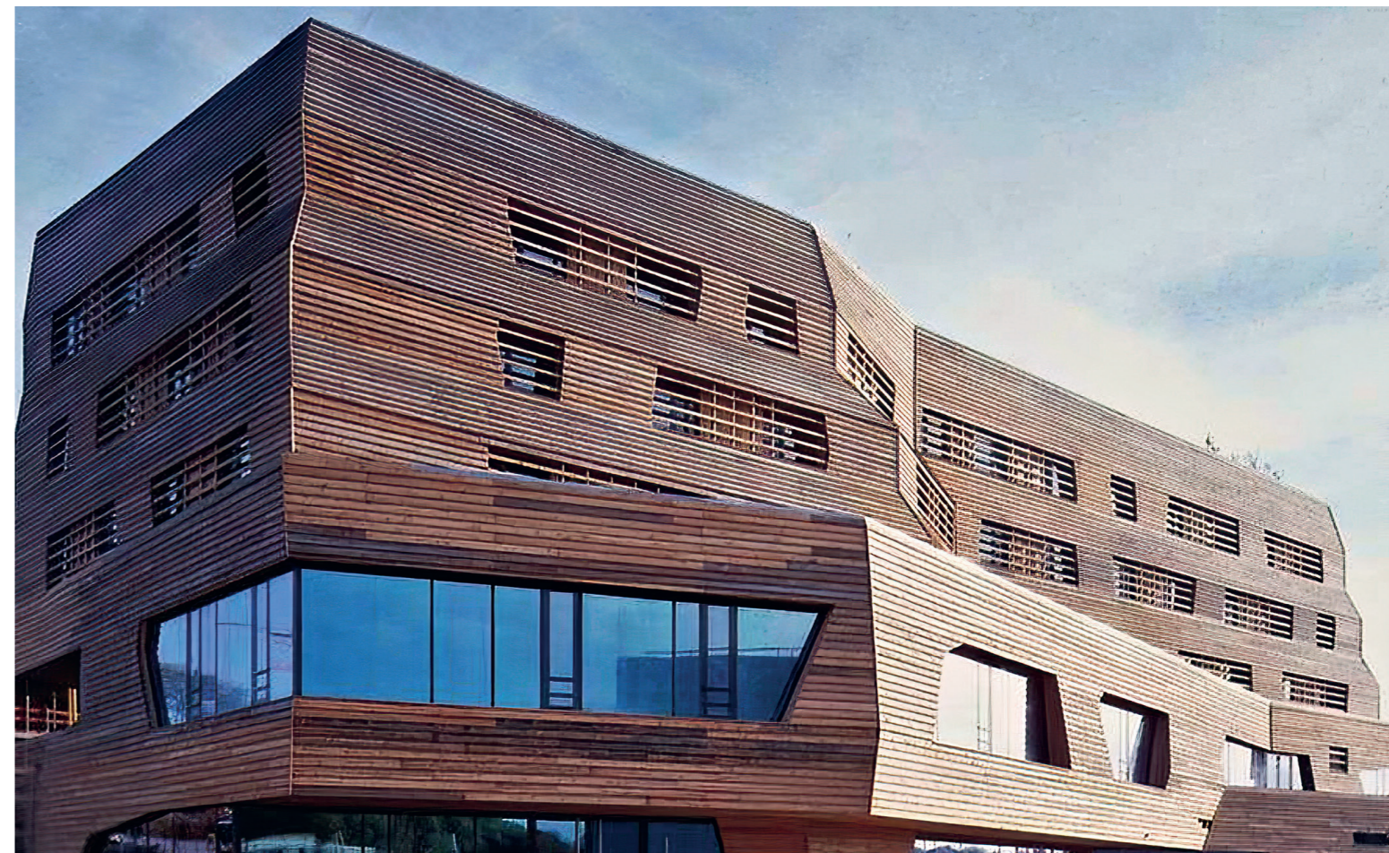
Bei unserer Erkundungstour über die Elbinsel Wilhelmsburg am 12. September besuchen wir viele interessante Orte, hier das Wälderhaus.
