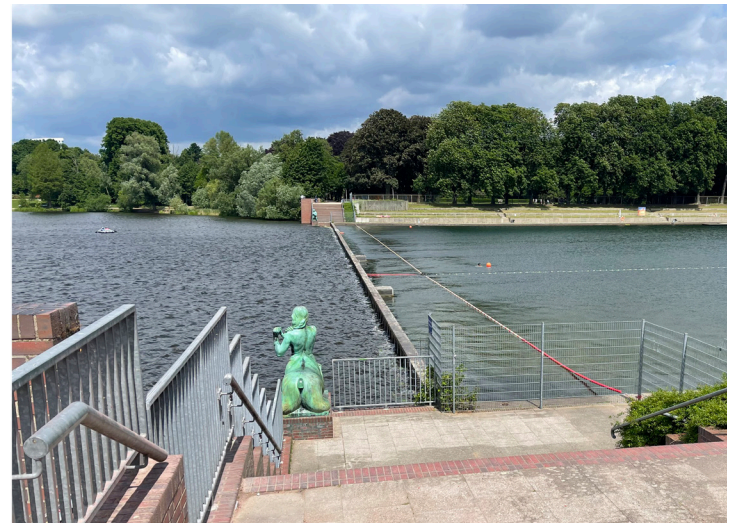
Bestand: unterschiedliche Absperrungen und die aus dem Wasser ragende Spundwand prägen den Badeteich
