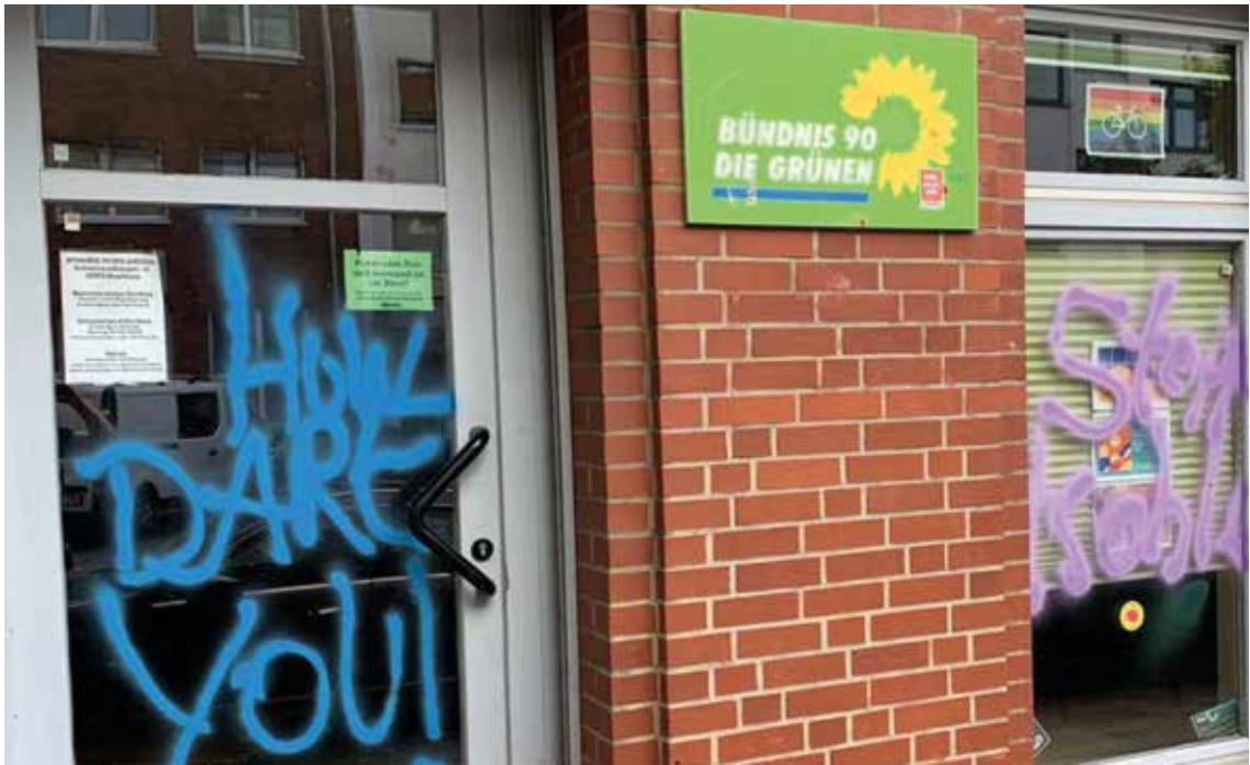
„How Dare You!": Im Oktober 2022 bewarfen unbekannte Personen ein Firmengebäude in Hamburg-Harburg mit Steinen und einem vermutlich mit Buttersäure befüllten Glasbehältnis um vorgeblich unzureichende klimapolitische Maßnahmen insbesondere der Partei „Bündnis 90/Die Grünen“ zu kritisieren.
