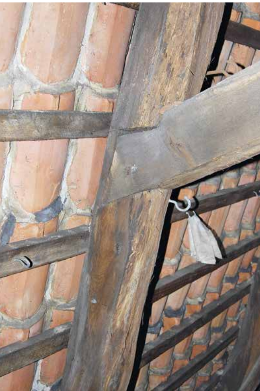
Historisches Dachwerk mit Schwalbenschwanzblatt und Tonpfannendeckung in Kalkmörtel.
