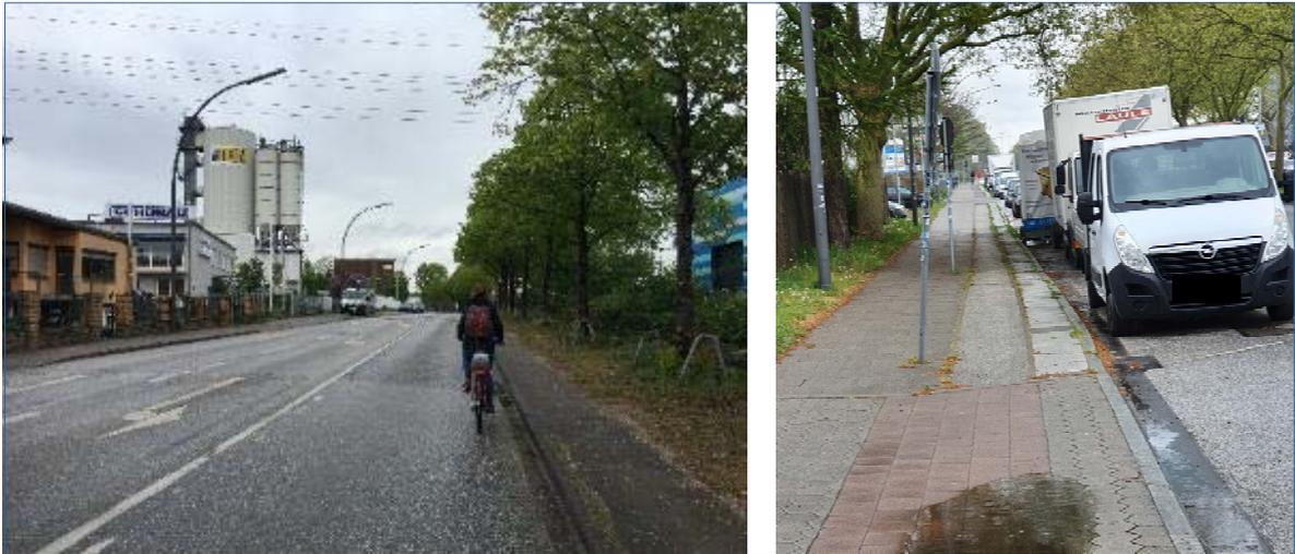
Abb. 43: Beschädigte, verbaute und unterdimensionierte Radwege am Standort
