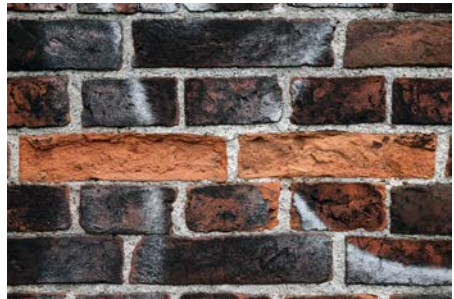
Abplatzung: Brennhautabscherbelung, Schalenbildung, Zersetzungen
