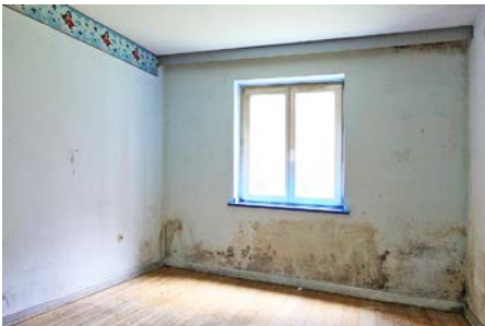
Feuchteschäden: muffiger Geruch bis hin zu Schimmel und Pilzbefall
