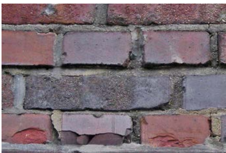
Abplatzungen: Übermäßige Pressungen und Überlastungen, Korrosion
