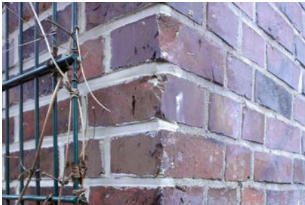
Missglückte Neuverfugung: neu links, rechts Bestand und Ausschnitt der Neuverfugung
