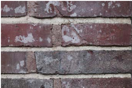
Ablösung von Antigrafittbeschichtungen
