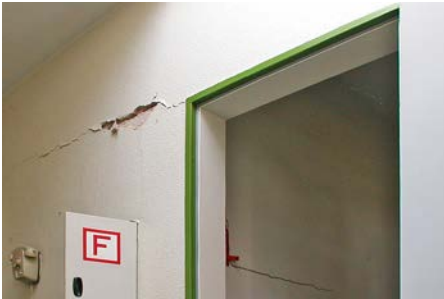
Risse im Putz innen: Setzungen des Bauwerks, statische Probleme
