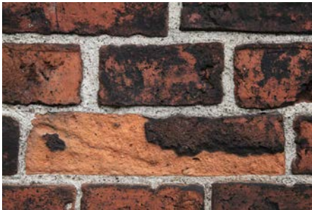
Abplatzung: Brennhautabscherbelung, Schalenbildung, Zersetzungen
