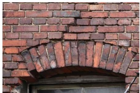
Klaffende Risse durch statische Veränderungen im Untergrund oder durch fehlende Sturzauflager
