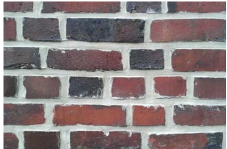
Missglückte Neuverfugung: neu links, rechts Bestand und Ausschnitt der Neuverfugung
