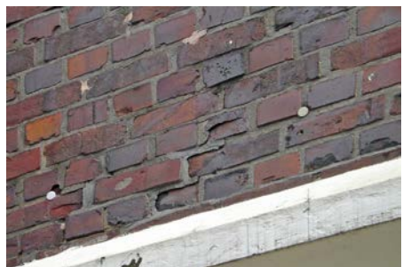
Abplatzungen: Übermäßige Pressungen und Überlastungen, Korrosion
