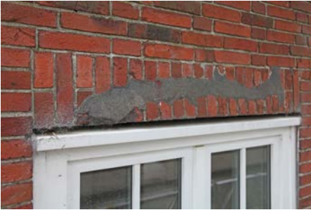
Fensteranbindung an Mauerwerk: Mangelhafte Sturzsanieung, teilentfugte Fensterbank
