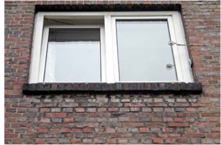
Fensteranbindung an Mauerwerk: Mangelhafte Sturzsanieung, teilentfugte Fensterbank
