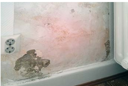
Durchfeuchtungen: Abplatzungen von Putz, Farbbeschichtungen oder Korrosion von Stahlträgern
