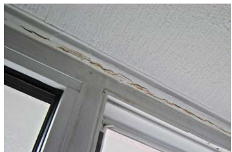
Durchfeuchtungen: Abplatzungen von Putz, Farbbeschichtungen oder Korrosion von Stahlträgern
