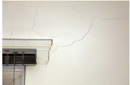
Risse im Putz innen: Setzungen des Bauwerks, statische Probleme
