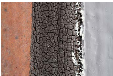
Undichte Fensteranschlüsse an das Mauerwerk
