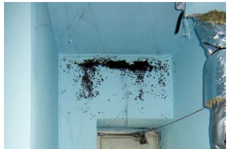
Feuchteschäden: muffiger Geruch bis hin zu Schimmel und Pilzbefall
