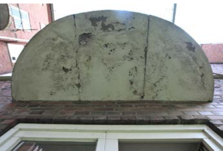
Angerostete Träger an den Balkonplatten
