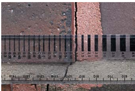
Klaffende Risse durch statische Veränderungen im Untergrund oder durch fehlende Sturzauflager
