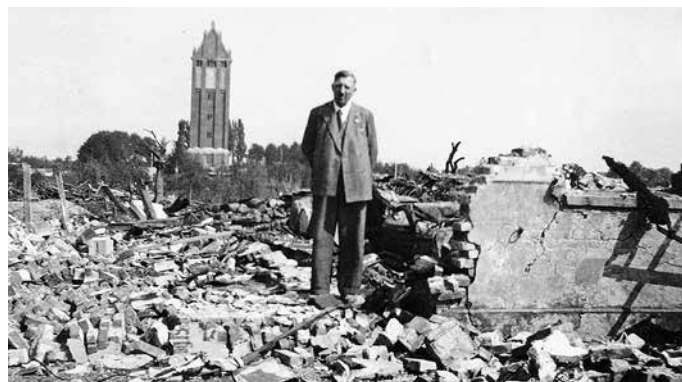
Die Gebäude im Privatweg waren komplett zerstört. Nur der Wasserturm hat den Bombenangriff überstanden.
