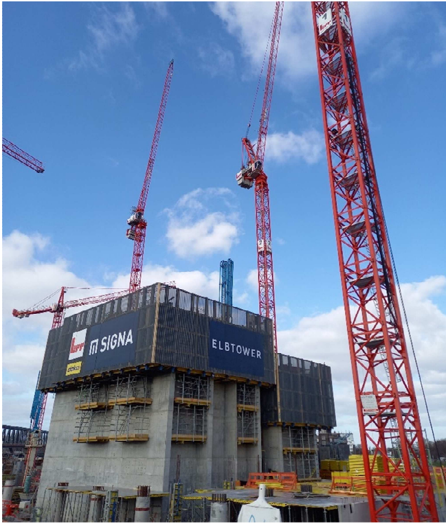
Der Elbtower, eine einzige Verschwendung von Baukapazitäten: Hier entsteht jedenfalls kein sozialer Wohnraum! (Foto: M. Joho)
