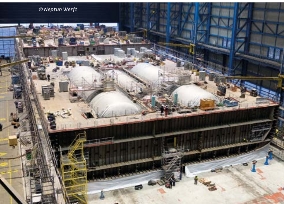
Sektionsbau: 140m langes Maschinenraum-Modul, mit vier Dual-Fuel-Motoren
