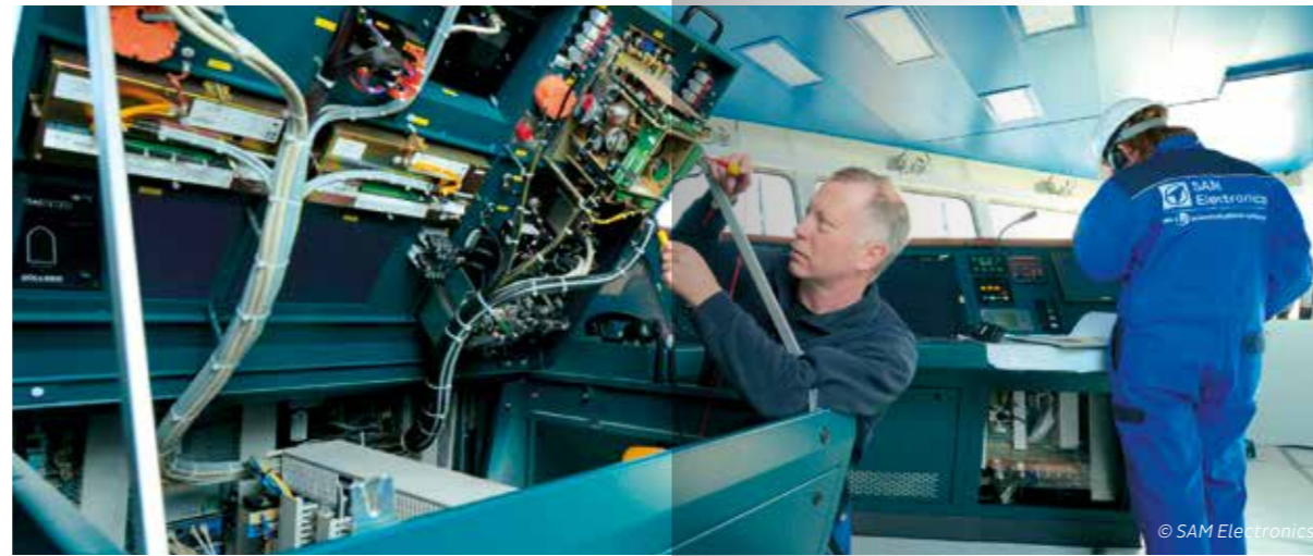
Inbetriebnahme eines Brückensystems
