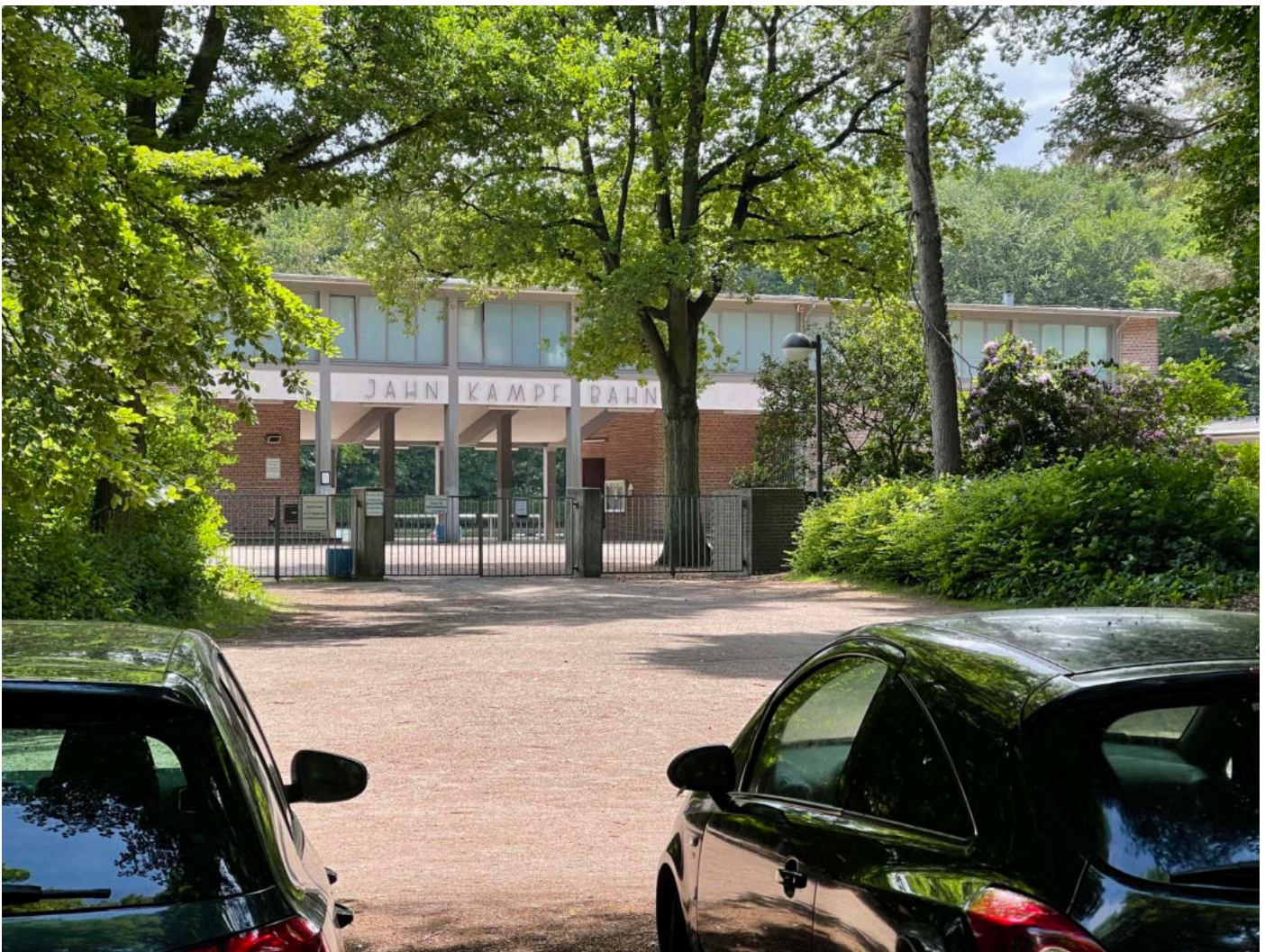
VERBOTE UND Absperrungen verhindern Zugang selbst zum Vorplatz, parkende Autos in Zentralachse
