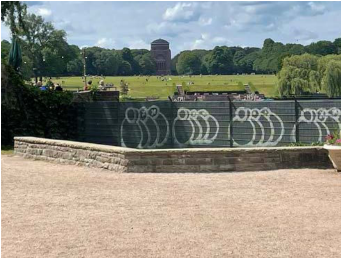
SICHTSCHUTZ MIT GRAFITTI VERSPERRT DEN BLICK AUFS WASSER
