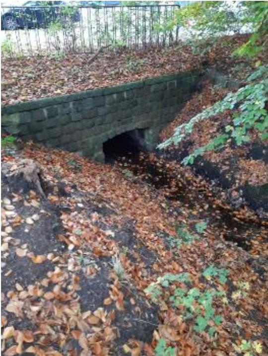
Abb. 3: tief eingeschnittener Gewässerquerschnitt und Querbauwerk mit Einengung des Gewässerquerschnitts
