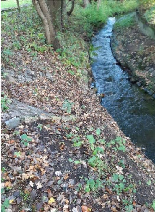
Abb. 17: Sohlgleite mit Uferbefestigung
