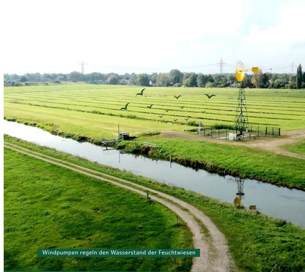
Windpumpen regeln den Wasserstand der Feuchtwiesen
