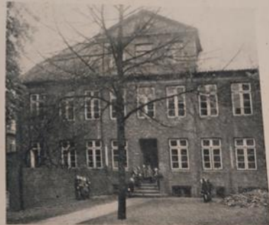
Bild 3. Schule am Klopstockplatz
