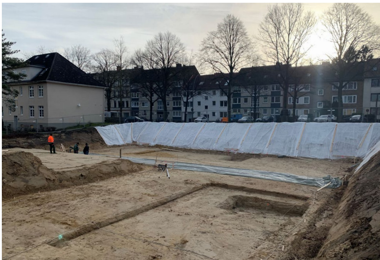
Baugrube für Gottschalkring 2 und Bremer Straße 136
