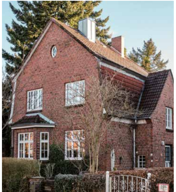
Die schönen Häuser sind durch eine spezielle städtebaulicher Erhaltungsverordnung geschützt - sie stehen nicht unter dem normalen Denkmalschutz.
