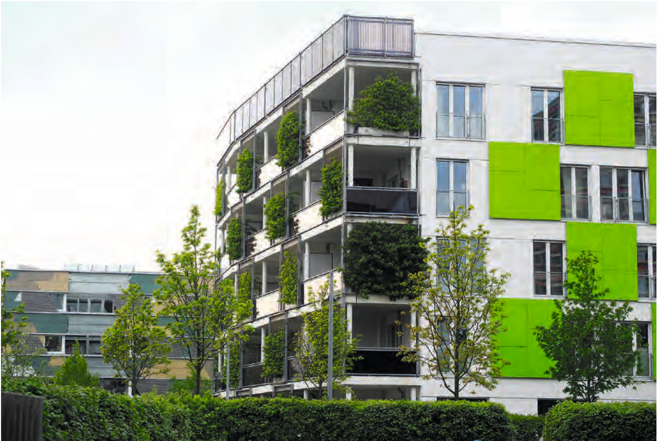
An die Südfassade des Passivhauses „Smart ist grün“ in Hamburg-Wilhelmsburg sind Pflanztröge angebracht, in denen Kletterhortensien wurzeln.
