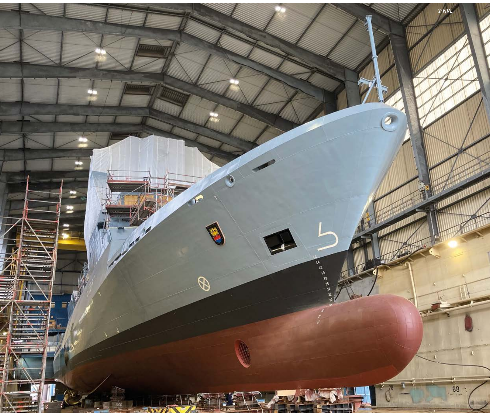
Die Emden nach dem Hochzeitsstoß kurz vor dem Ausdocken bei Blohm+Voss
