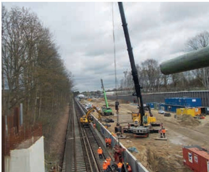
Blick Richtung Ohlsdorf. Neben Gleis 2 die Betonmauer zur Vermeidung des Abrutschens des höher liegenden Planums. Links vorn der Pfeiler für die neue „Paul-Stritter-Brücke“.
