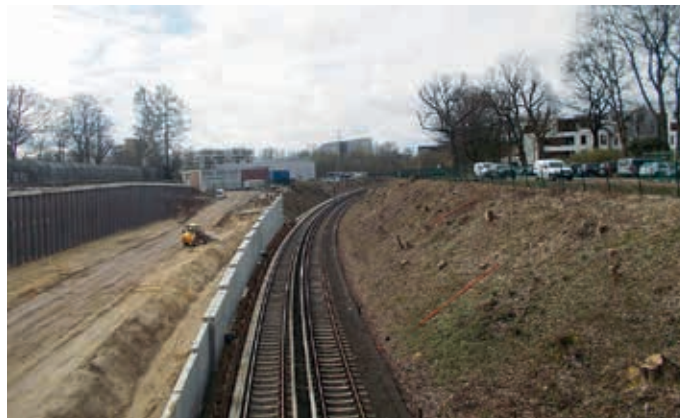
Richtung Alsterdorf steigt die Trasse der U 1 wieder an, um anschließend die Sengelmanstraße zu überqueren.
