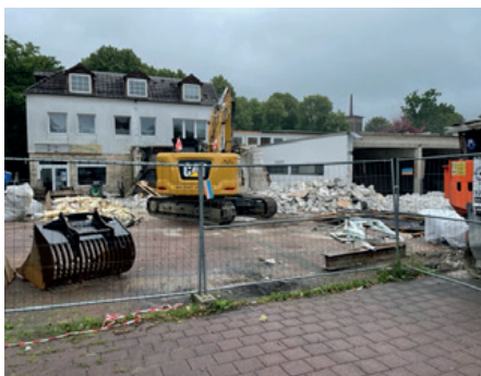
Abb.: Der an der Poppenbüttler Hauptstraße im Abriss befindliche ehemalige Aldi-Markt (Quelle: Harald Clemens)
