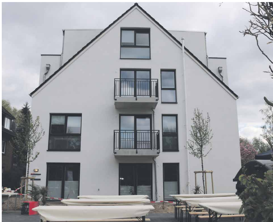
Seit Ende November 2022 sind nach und nach die minderjährigen unbegleiteten Ausländer in die neue Clearingstelle Erstversorgung im Pulverhofsweg eingezogen, seit April ist die Einrichtung voll belegt. Im Rahmen mehrerer Informationsveranstaltungen wurde ein intensiver Austausch mit der Nachbarschaft gepflegt. Foto: Bormann
