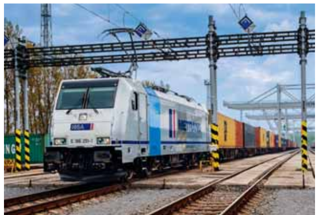
Der neue Metrans-Terminal macht Rangieren überflüssig.
