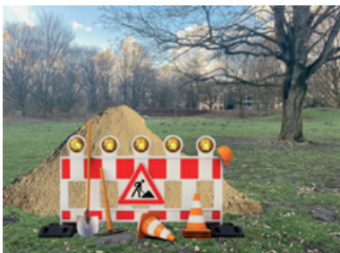
Baustelle ab 1. April Foto: Philip Scherer
